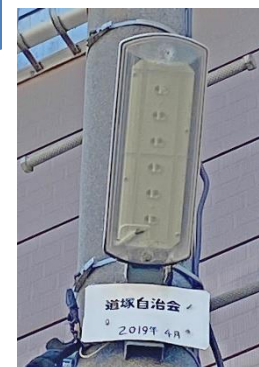
防犯灯(街灯) 町内123灯設置
